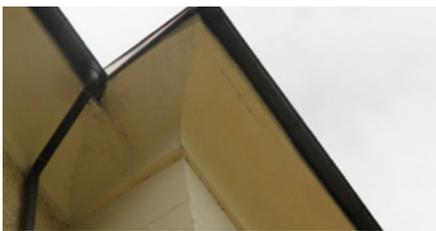
Beschädigtes Gesims durch Wasserinfiltration, Nordseite
